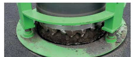
Millimetergenaue Fräsung über der Schachtöffnung
