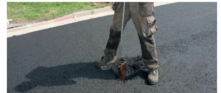
Präziser Rohrdurchzug ohne vorheriges Einmessen
