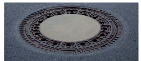
Plangenaue Schachtdeckung für leises Fahrbahnbild
