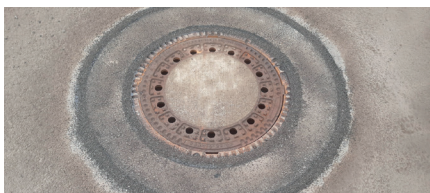
Schachtsanierung und Asphaltherstellung kombiniert
