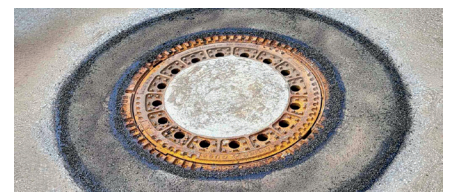
Geräuscharmer und belastbarer Schachtabschluss
