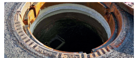
Zweifache Heißbitumen-Ver-siegelung mit Quarzsand-Finish
