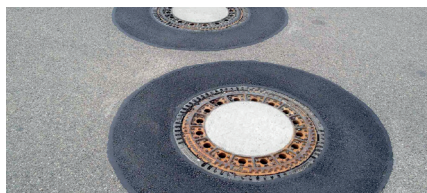
Doppelte Dehnfuge für maximale Langlebigkeit
