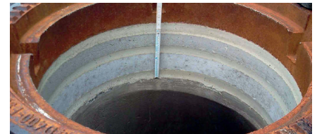
Stabiler Schachtaufbau bis Oberkante
