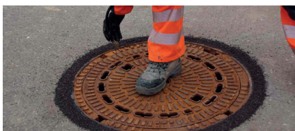
Optimale Einbaugüte durch eigene Minimisanlagen
